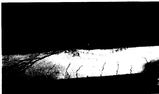
図-13 破RC断面供試体の壊状況
