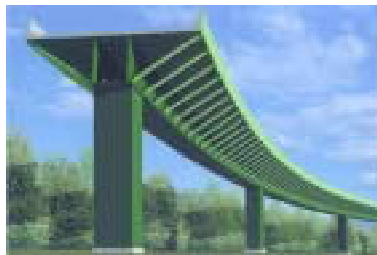
図-1 ストラット付鋼単箱桁橋
