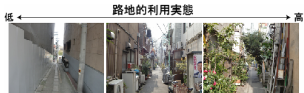
3枚の写真は全て幅員4m未満であり、どれが路地でどれが路地ではないという明確な区切りは無く、右に行くほど路地的利用実態の高い路地であり、左に行くほど路地的利用実態の低い路地である。
