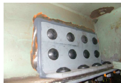
写真-1 接着剤を併用した鋼板当て板工法
