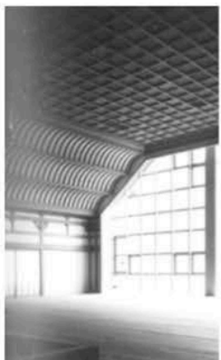
図-21 妙縁寺 本堂写真
