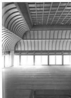
図-16 妙源寺 本堂写真
