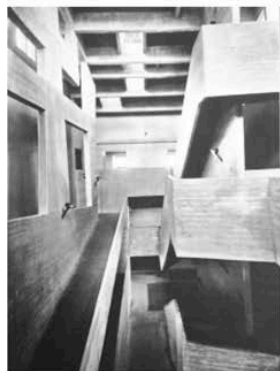
図-5 大化城 階段室写真
